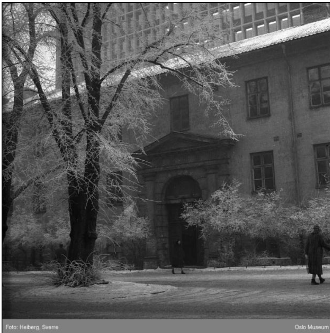
Figur 14.4. Rikshospitalet i Grubbegata kort tid før riving. Regjeringskvartalets nye høyblokk i bakgrunnen. (Foto: Sverre Heiberg 1959)
