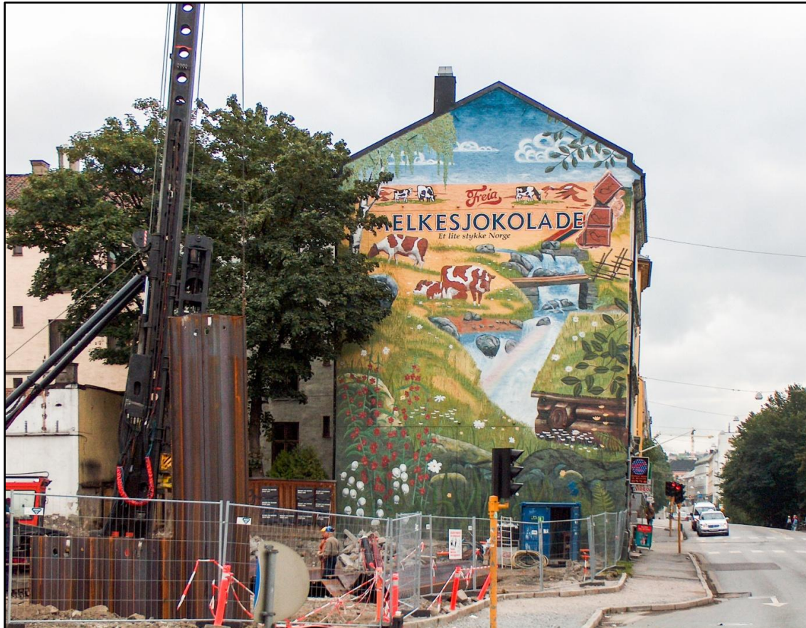
Figur 24.13. "Third places" – men for hvem? Gavler, løkker og mer eller mindre utilgjengelige byggeplasser utgjorde lekemiljø for barn i indre Oslos vekstfase. Her tettes et av de siste hull i fasaderekken ved Alexander Kiellands plass i Oslo i 2004. Byenes ubebygde tomter var "et lite stykke Norge" som nå stort sett er borte. (Foto: Øivind Larsen)
