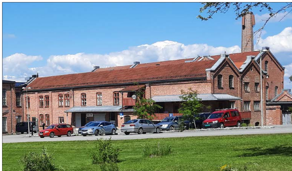
Figur 5: Fabrikkanlegget har vært et konglomerat av bygninger med stadige tilbygg og forandringer. Dette fotografiet fra 2022 er tatt fra samme side av fabrikkens som bildet fra ca. 1912. (Foto: Øivind Larsen)
