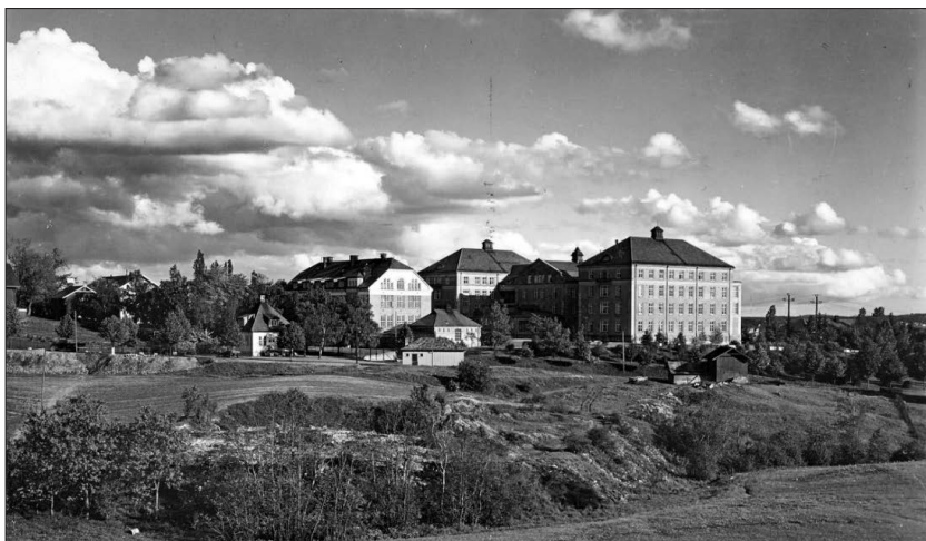
Figur 1. Aker sykehus fotografert av Karl Harstad (1890–1976) en gang i perioden 1935–40. Det er ikke godt å kjenne seg igjen i dag. Gårdsanlegget der museet ligger, er ytterst til venstre på bildet. Flere deltakere på seminaret i 2023 var barn da sykehuset så slik ut. Museet har som oppgave å dokumentere forandringene som skjer jevnt og trutt. (Oslo Museum OB.F11490)
