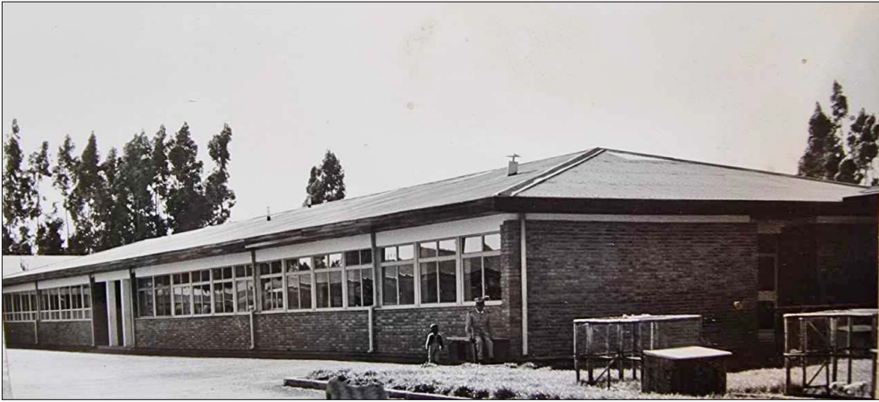
Figur 2. Den første instituttbygningen i Addis Abeba.
