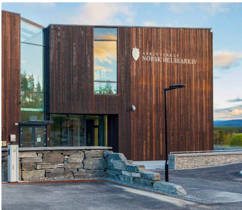
Figur 2. Norsk helsearkiv på Tynset ble nominert til Arkitekturprisen 2019. Pasientjournalene oppbevares like trygt som i sykehus, og det er ikke lov å fotografere innendørs. (Foto: Statsbygg/Trond Isaksen)
