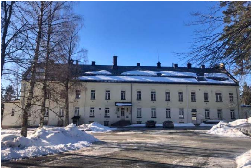
Figur 1. Foto av bygningen Bjørkeli fra øst. Foto Kjell Martin Moksnes, 2024.
