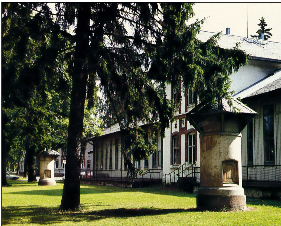
Figur 7: Ullevål sykehus – epidemilasa rett fra 1887 med europeiske forbilder. Ventilasjonstårn for luftinntak i forgrunnen. (Foto : Øivind Larsen 1986)
