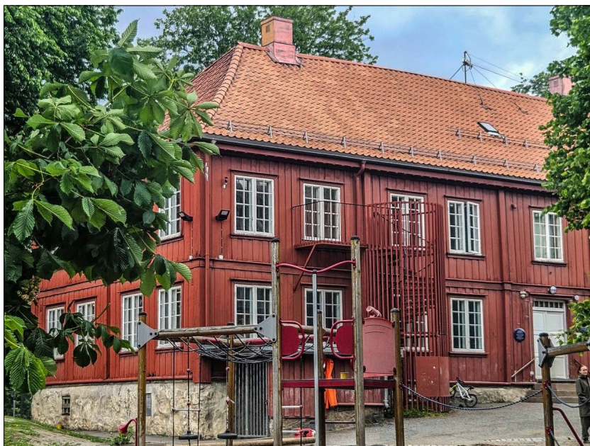
Figur 5: Løkken Bellevue på Tøyen ble overtatt av kommunen i 1898 for å brukes som tuberkulosesykehus. Opprinnelig professorbolig, nå barnehage (Foto: Øivind Larsen 2026)
