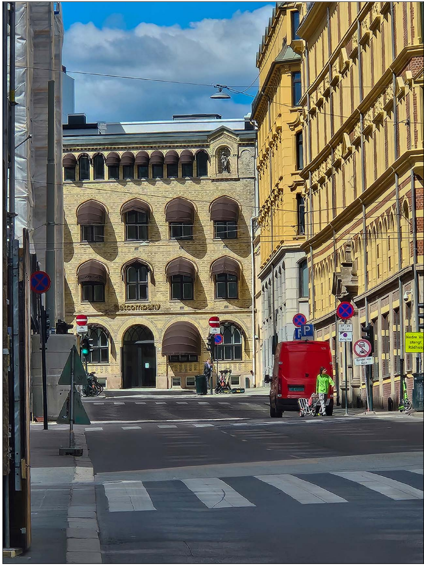
Figur 4: Øvre Vollgate 15 i Kvadraturen i Oslo sentrum, nå Bokhandlernes Hus, ble bygd i 1860 og var i sin tid lokaler for Nissen Pikeskole. Det er nå intet som minner om at huset i 1900 ble leid til bruk som sykehus for 70 indremedisinske og kirurgiske pasienter. Slik er det også for mange adresser som nevnes i historien om byens sykehusvesen. (Foto: Øivind Larsen 2026)
