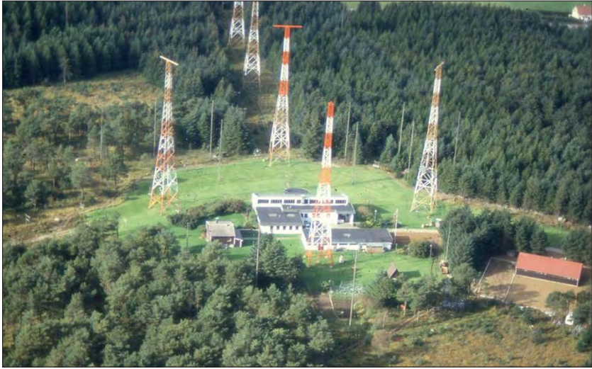
Figur 37 I Vigreskogen, 20 kilometer fra mottakerne lå sendestasjonen på 600 kvm. Der ble det i 1959 reist ti av de 50 meter høye ståltårnene som bar senderantennene. Foto: Ukjent/telemuseet, Vigreskogen ca. 1970.
