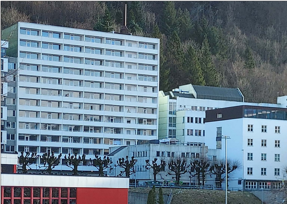
Figur 3: Her er de sentrale bygningene for instituttets virksomhet mot slutten av 1990-tallet. I front ses det to-etajers undervisningsbygget Appendix med inngang og trappehus mot parkeringsplassen, med gangbroen bak til sykehuset. Til venstre for Appendix er Ulriksdal 8c med instituttlokalene fra 1972 og etter ombyggingen i 1991 og senere. Til høyre for 8c ligger SMU-bygget, med undervisningslokaler og kontorer. Det var få meters gange fra dør til dør på baksiden, men man kunne ikke gå tørrskodd. Sammenbygd med SMU-bygget ligger så sykehuset, der instituttet hadde auditorium og klasserom i 5. og 6. etasje. Foto: UiB.
