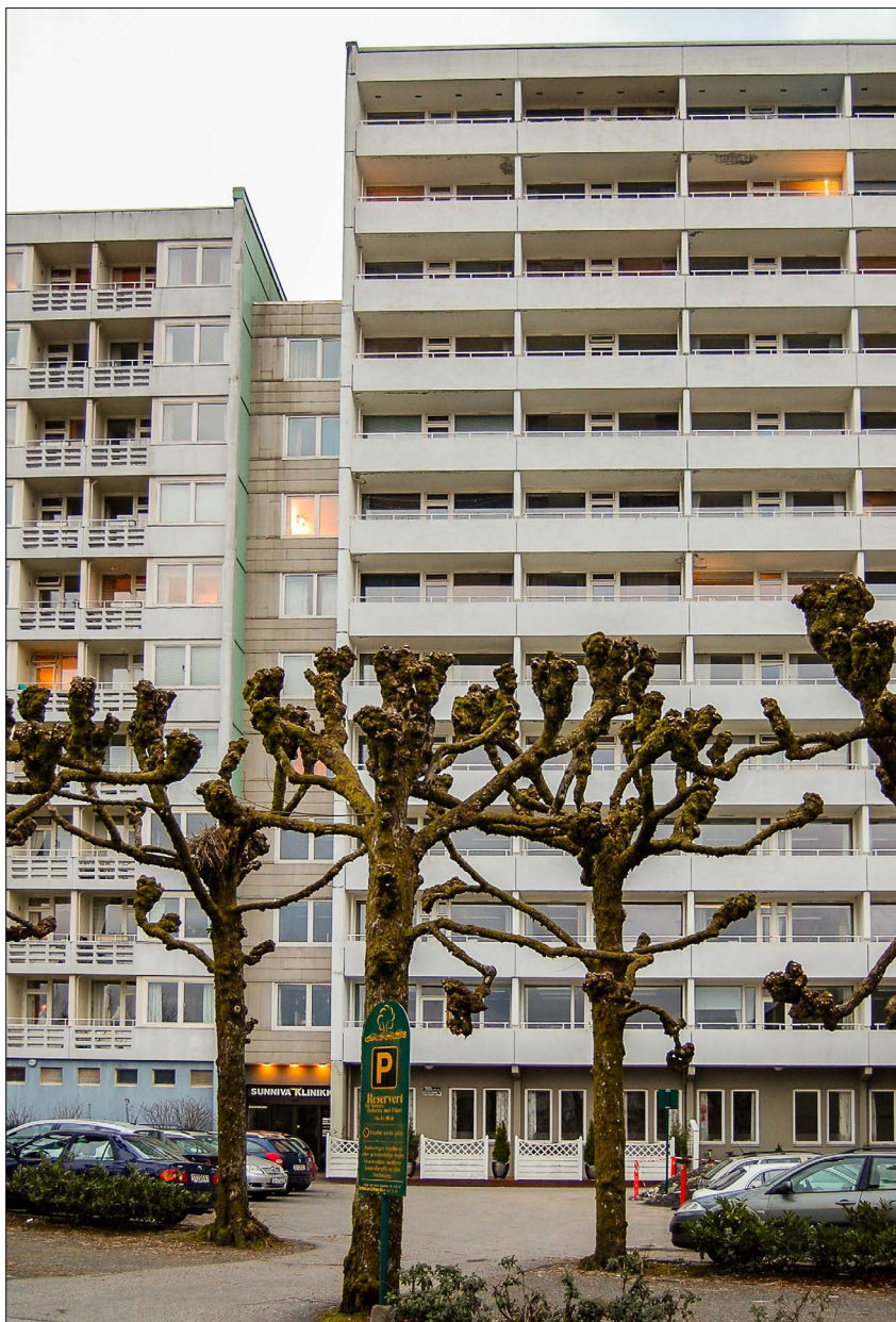
Figur 1: Ulriksdal 8c fotografert i 2009. Man ser det meste av høyblokken og mellombygget mot naboblokken 8b og parkeringsplassen i forgrunnen. Inngangspartiet i midten var til legesenteret i andre etasje og til kantinen inn til høyre i første etasje. Etter ombyggingen var hovedinngangen ved heishuset til høyre utenfor bildet. Ved innflyttingen disponerte instituttet de fire nederste etasjene. Foto: B. Ystebø/flickr.
