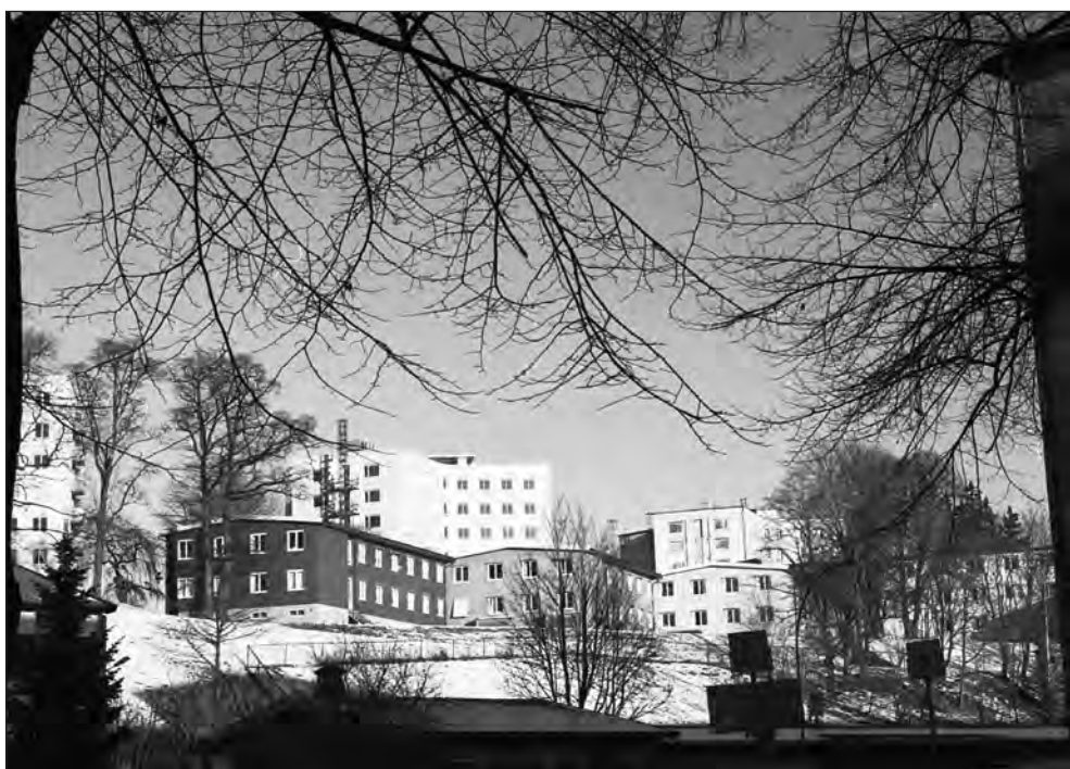
Figur 10: Det tidligere søsterelevhjemmet på Ullevål sykehus ble bygg for mesteparten av Institutt for allmenn- og samfunnsmedisin. Her er bygget fotografert i 1999, før Ullevåls kreftsenter ble bygd, og det var godt synlig fra sykehusområdet. (Foto: Øivind Larsen)
