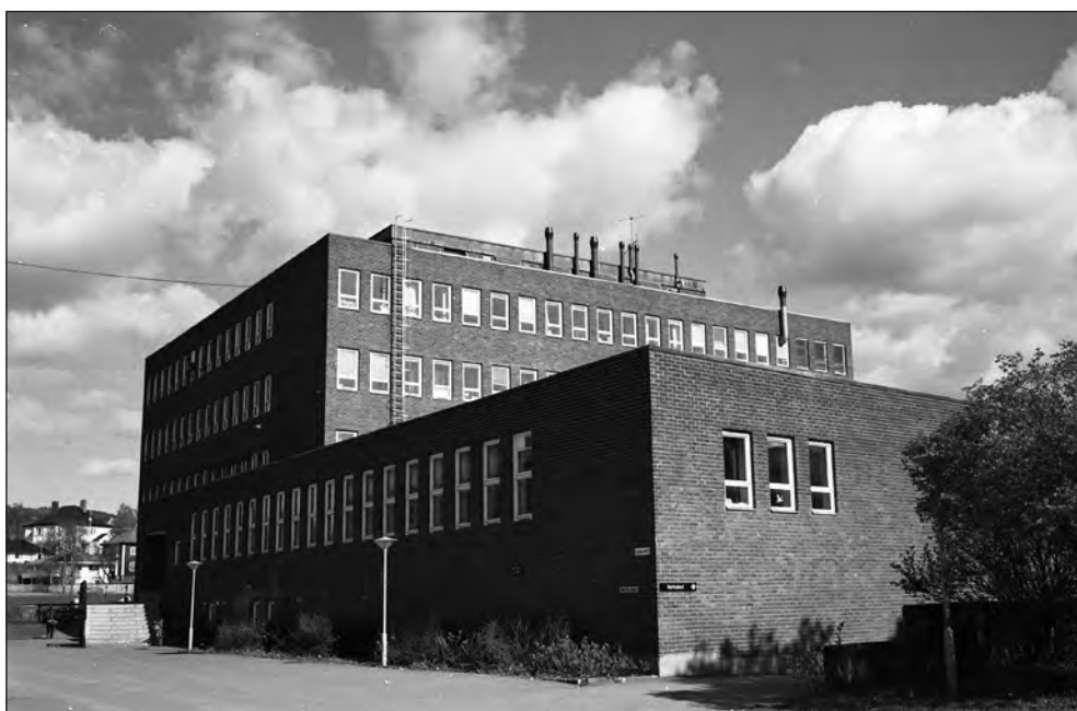
Figur 5: Gydas vei 8 ved Majorstua, slik bygget så ut i 1989. Institutt for forebyggende medisin, det tidligere Hygienisk Institutt, holdt til i fjerde etasje. Laboratoriene var vendt mot forsiden og ballplassen, mens kontorene lå mot forsiden og mot sydøst. Dyrestallen var i den inntrukne loftsetasjen. Bygget hadde inngangsparti til venstre på bildet. Innenfor lå en stor kurssal for det praktiske laboratoriekurset i hygiene, og innerst i gangen var auditoriet som fortsatt er der i lavblokken. Inn til høyre for inngangen lå også byggets bibliotek, som Hygienisk Institutt hadde felles med Arbeidsforskningsinstituttene. (Foto: Øivind Larsen)
