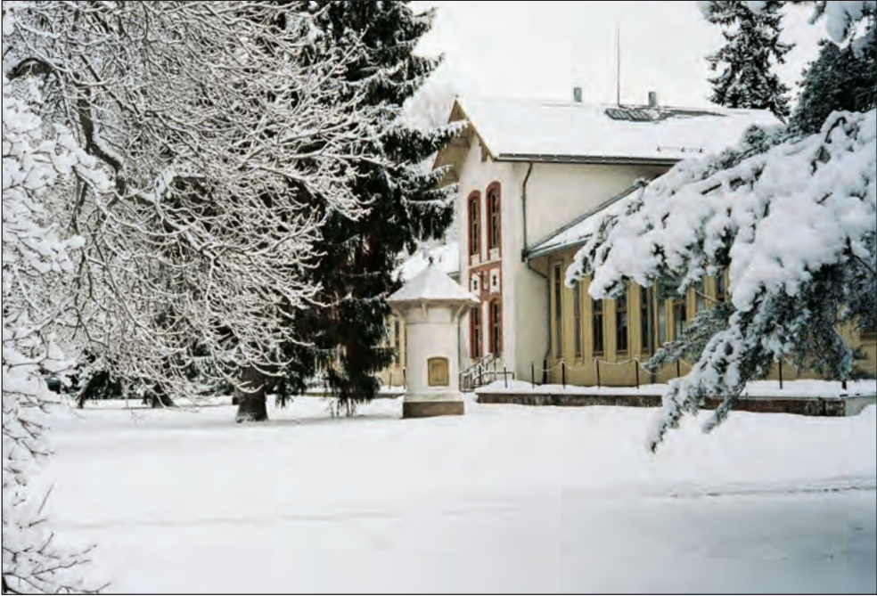
Figur 48: Den eldste delen av Ullevål Sykehus, åpnet 1887, var bygd som epidemilasarett etter mønster av tilsvarende sykehus ute i Europa. Frisk luft ble tatt inn gjennom de karakteristiske ventilasjonstårnene på plenen utenfor, ført gjennom sykesalene og ut gjennom ventilasjonspiper over tak. Her fikk studentene undervisning om smittsomme sykdommer så lenge sykeavdelingene var i bruk. I 2014 er det bare en av de opprinnelige trepaviljongene som har unngått riving. Den er nå sykehusmuseum. (Foto: Øivind Larsen 2013)
