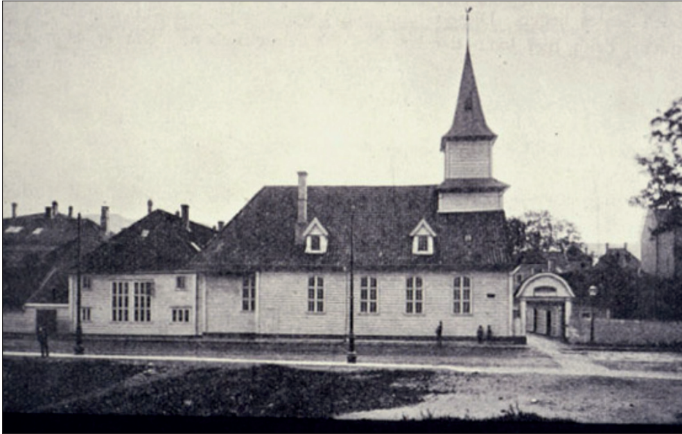
Figur 1: St. Jørgens Hospital (til venstre i bildet) og hospitalskirken (7).
