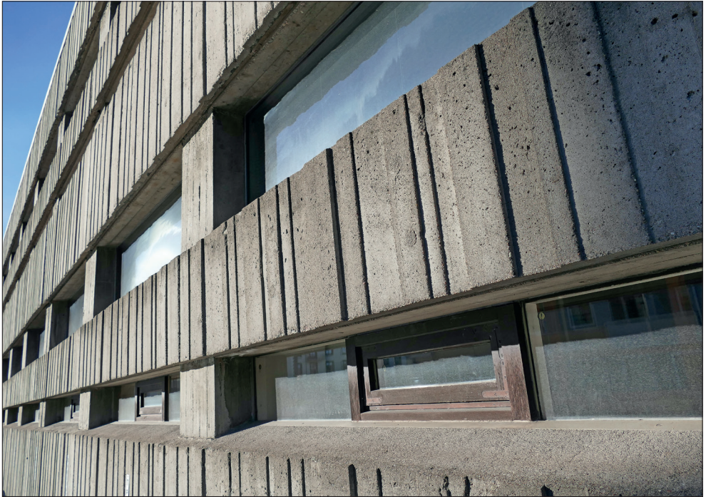
Figur 6: Det nye hovedbygget fra 1969 ble bygget i en brutalistisk stil. (Foto: Øivind Larsen 2019)
