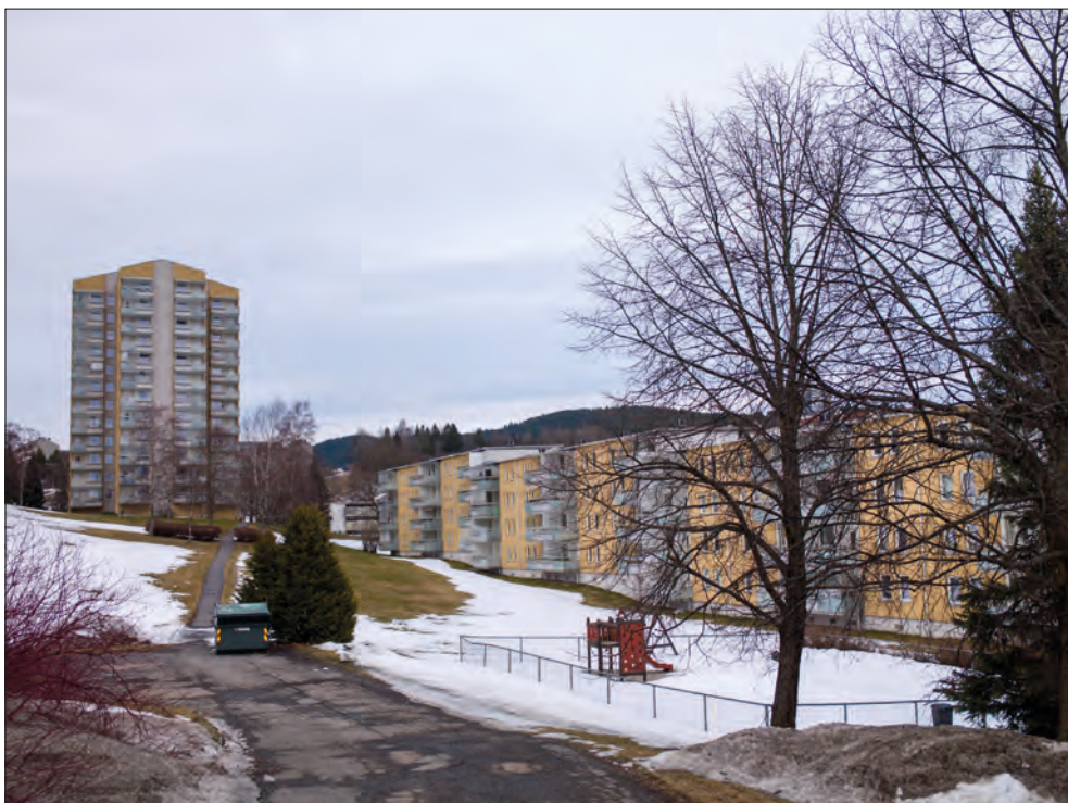
Figur 12: Utformingen av arealene mellom boligblokkene gjør det ofte vanskelig å vurdere hva som er offentlige, halvoffentlige, halvprivate og private soner. Det påvirker hvordan arealene brukes, og hvem som er villige til å vedlikeholde dem. (Foto: Gunnar Ridderström 2019).
