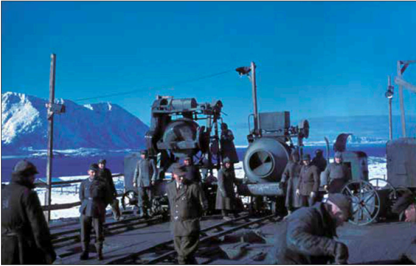
Figur 7: Østeuropeiske krigsfanger i arbeid på Gossen. Bilde tatt av tyske soldater. (Romsdalsmuseets fotoarkiv.)
