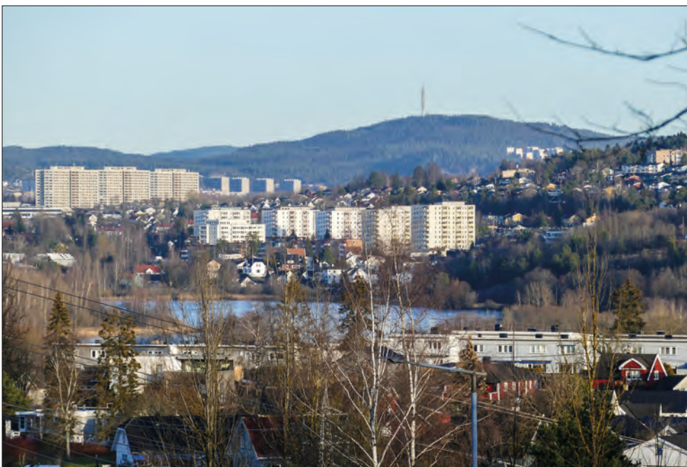
Figur 3: Bildet dekker flere bydelstyper: I det fjerne til venstre ser vi høyblokkene på Tveita (bygd 1967-1969) i bydel Alna, og langt borte, helt til høyre, skimtes blokkene på Romsås i bydel Grorud, oppført i løpet av 1960- og 1970-årene. Begge disse stedene tilhører bydelstype 4 (Oslo ytre øst). Helt i forkant av bildet ser vi Østensjøvannet. Rundt dette ligger bydel Østensjø som er i bydelstype 2 (Oslo sørvest, tabell 2). Her er det en villa- og lavblokkstrøk som strekker seg rundt vannet, med større blokker og fortetting rundt knutepunktet Oppsal midt på bildet. (Foto: Øivind Larsen 2020)
