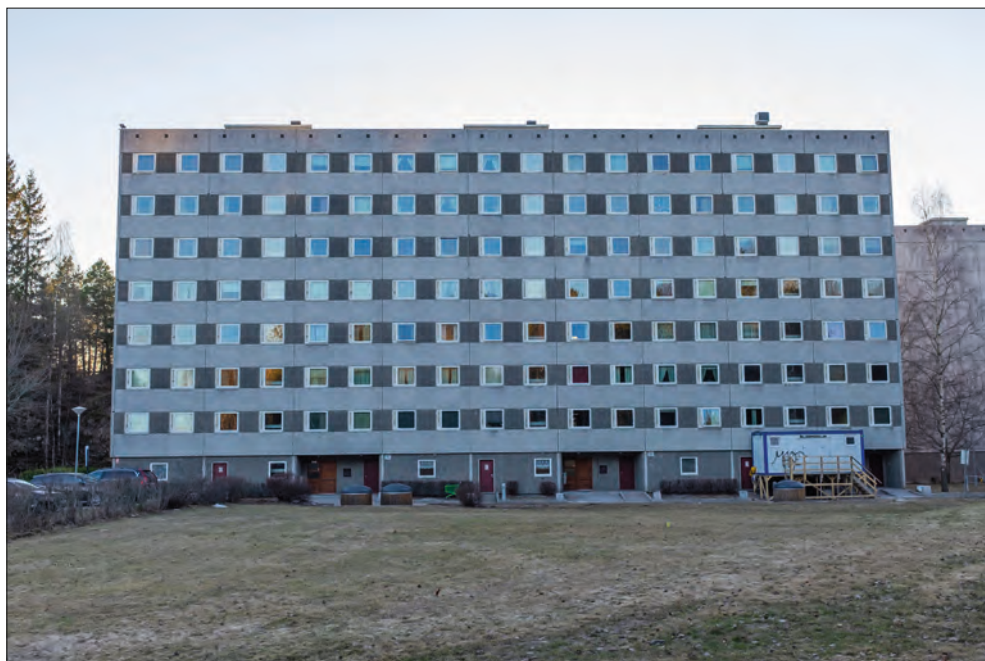
Figur 2: Dimensjonene og plasseringen av boligblokkene sprenger den menneskelige skalaen vi forbinder med den tradisjonelle byen. Haugenstua borettslag består av 882 leiligheter. (Foto: Gunnar Ridderström 2019)
