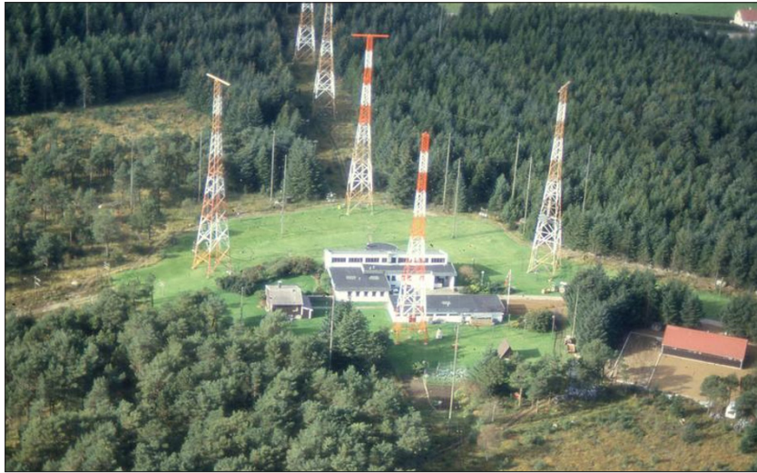
Figur 37 I Vigreskogen, 20 kilometer fra mottakerne lå sendestasjonen på 600 kvm. Der ble det i 1959 reist ti av de 50 meter høye ståltårnene som bar senderantennene. Foto: Ukjent/telemuseet, Vigreskogen ca. 1970.
