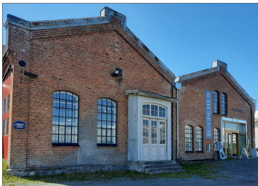
Figur 3: De staselige, gamle industribygningene på Kapp på Toten ble reist i tidens stil i rød teglstein i perioden 1891–1920. Her er det nå kulturskole og flere andre aktiviteter som minner lite om anleggets opprinnelige formål. Men i fasaden som er vendt ut mot Mjøsa, finner vi inngangen til museet «Mjøsas Ark». Hvis vi går inn der, lærer vi fort at på dette stedet var det for litt over hundre år siden liv og røre av stort omfang – bygningene tilhørte Melkefabrikken som var i drift her fra 1891 til 1942. (Foto: Øivind Larsen 2022).
